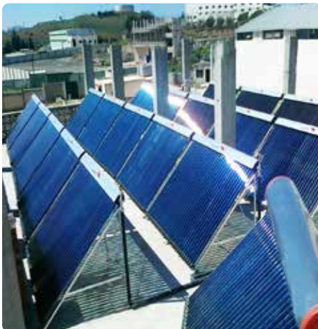
Panneaux chauffants solaires pour toitures d'appartements
